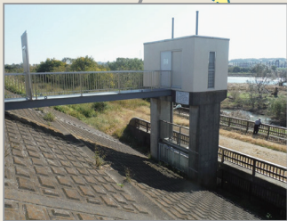
猪方排水樋管
