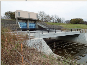
六郷排水樋管
